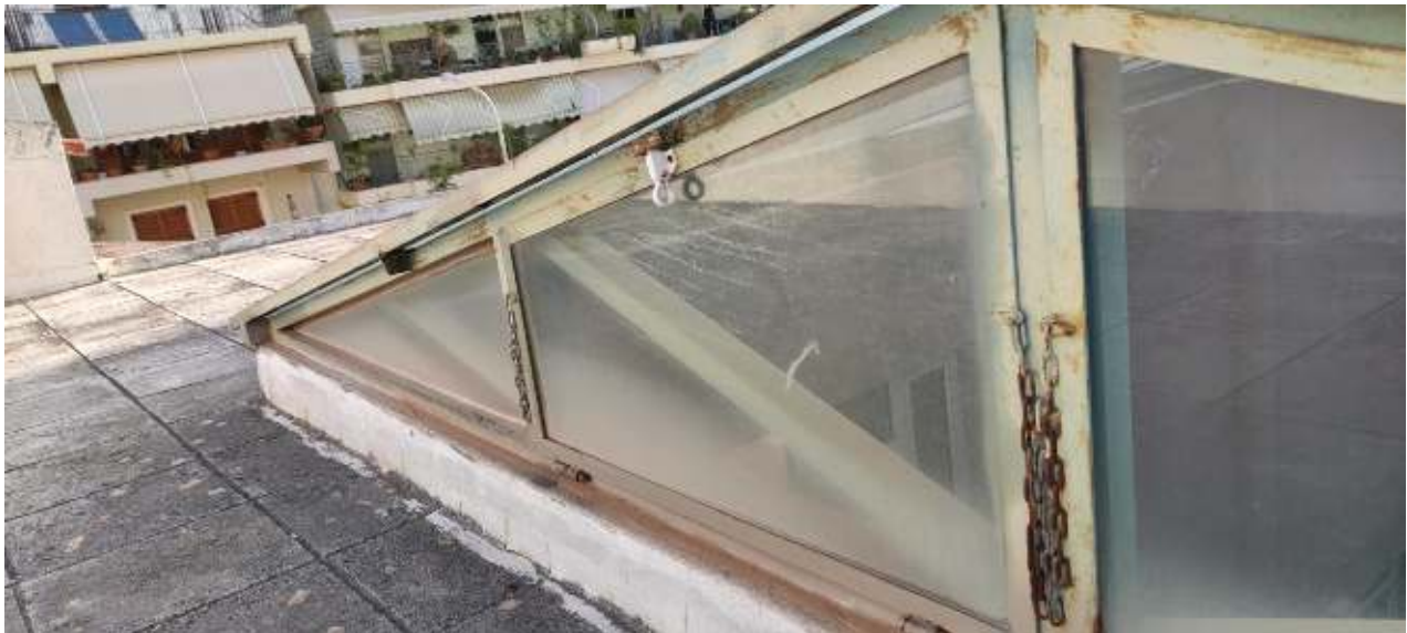
Εικόνα 4 Αίθριο ΚΨΥ, λεπτομέρεια εξωτερικής πλευράς αετώματος.
