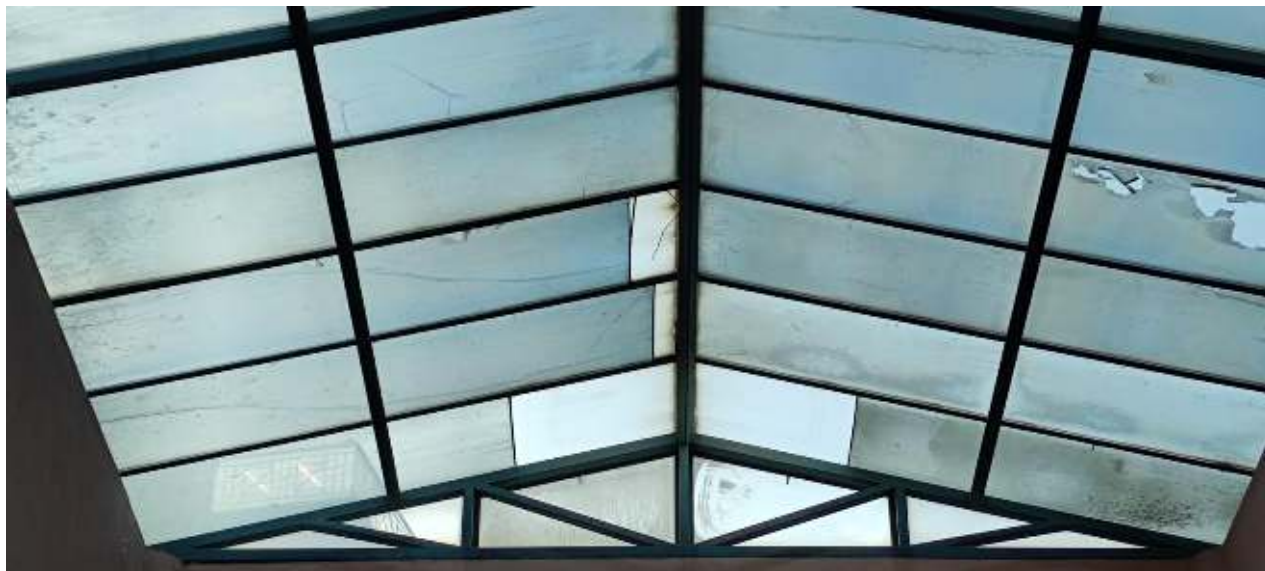
Εικόνα 2 Αίθριο ΚΨΥ, άποψη αετώματος.
